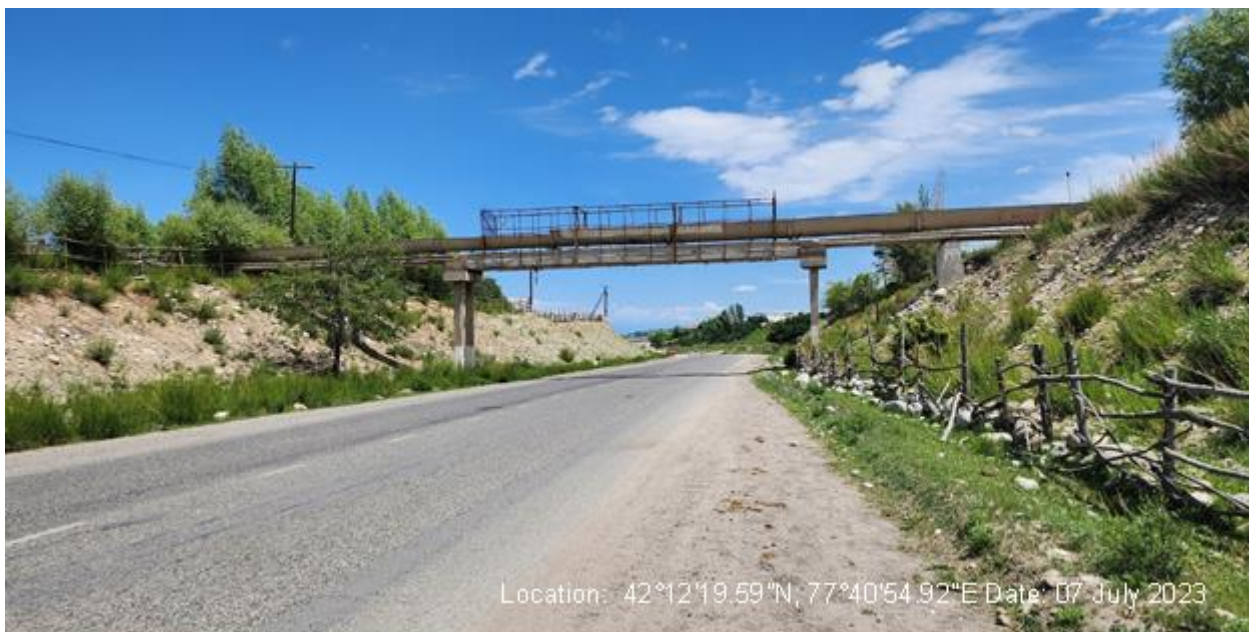
Рис. 14: Существующий водовод, подлежащий замене (КМ 149+326.0).
