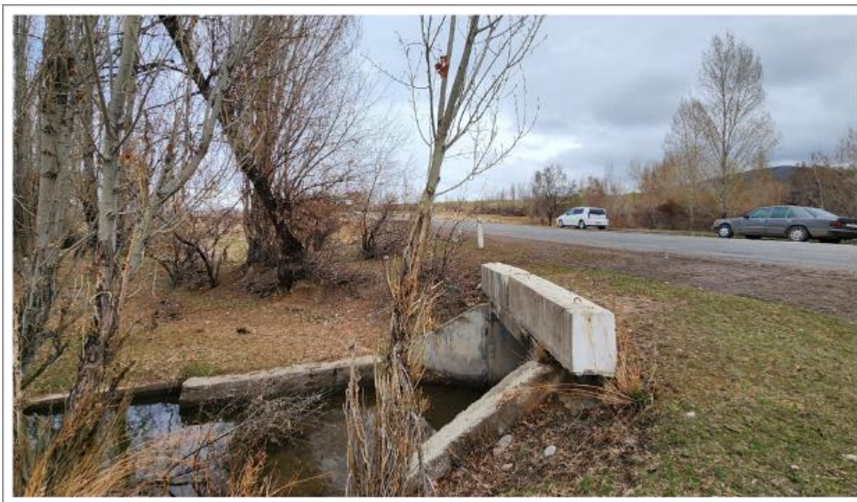
Рис. 197: Существующая водопропускная труба
