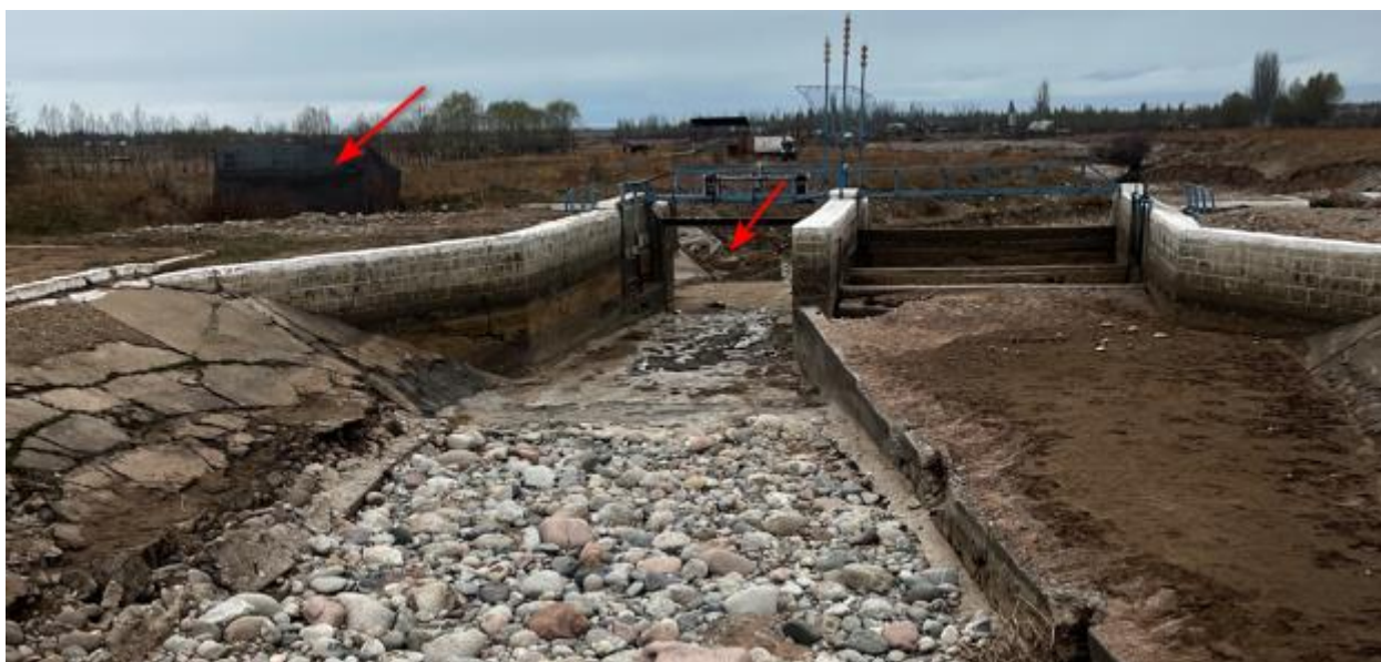
Рис. 70: Демонтированное гидротехническое сооружение Джети-Огузского моста.
