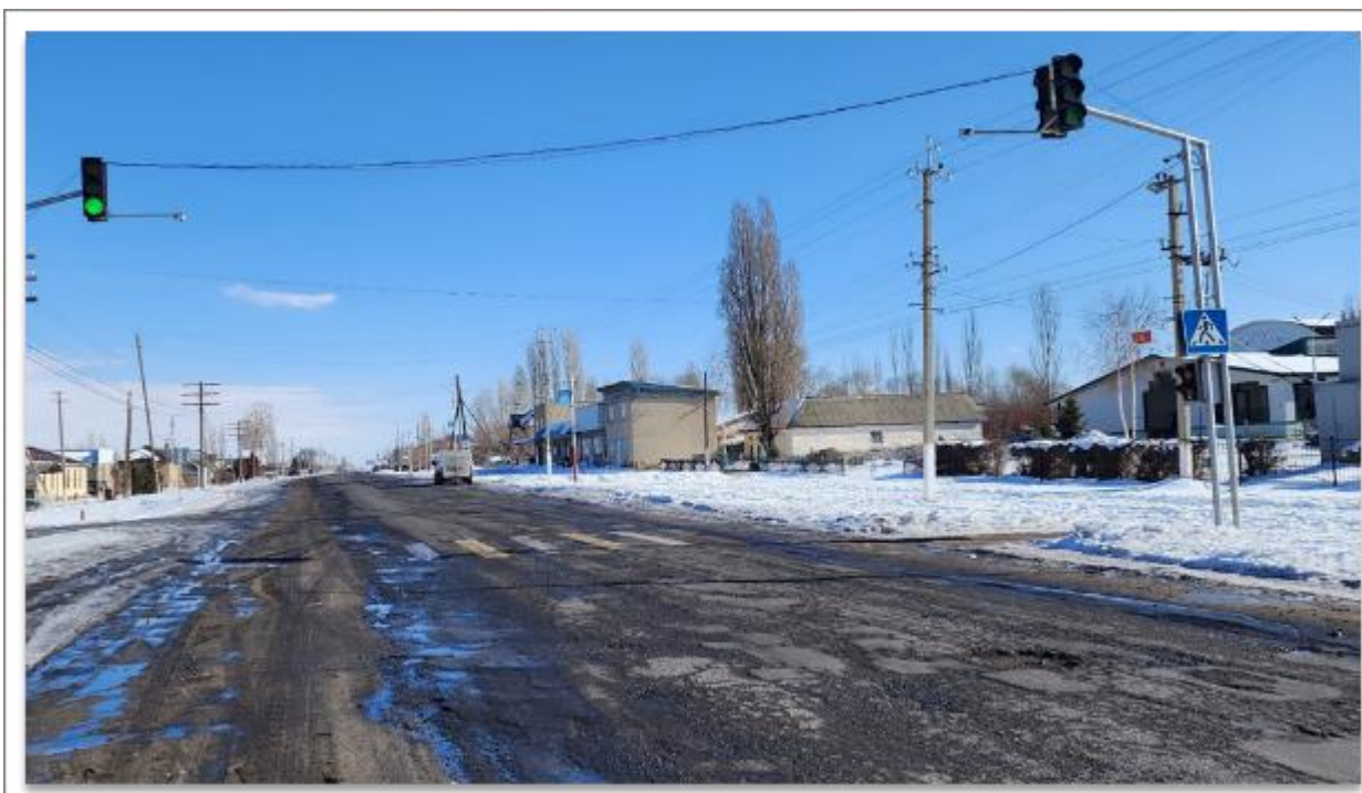
Рис. 185– Существующее состояние дороги в Дархане
