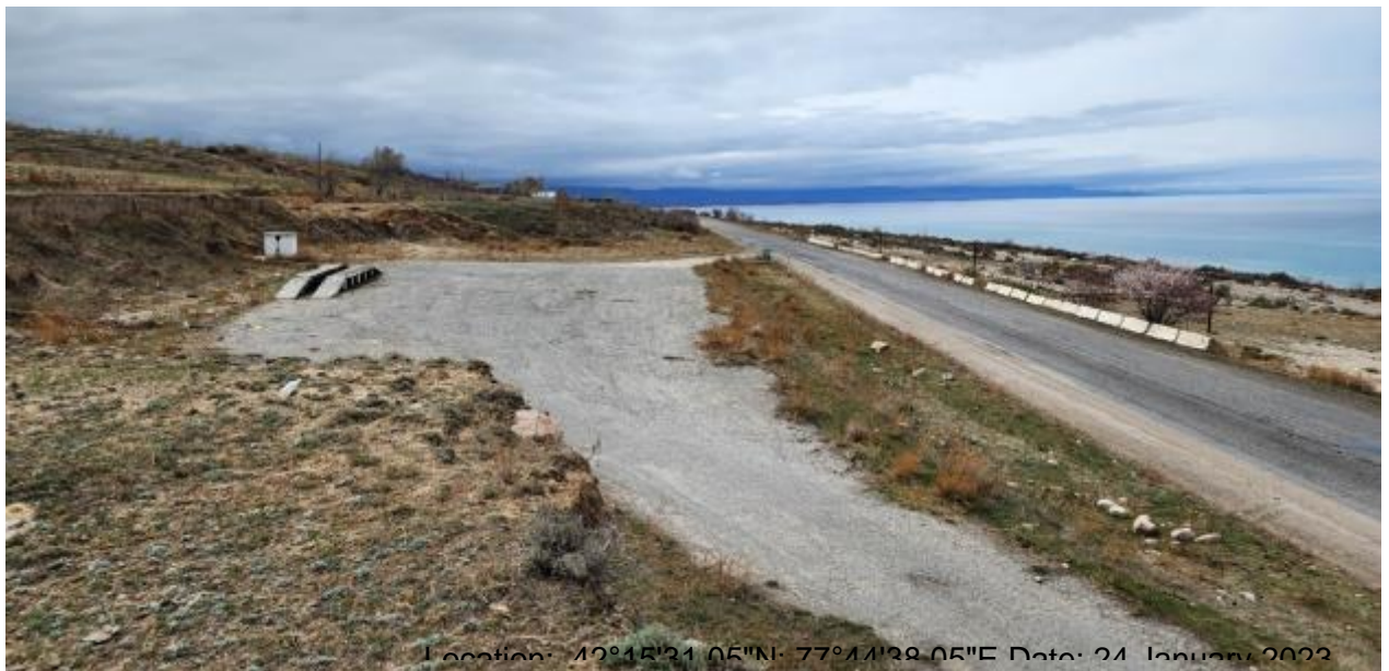
Рис. 19: Существующая стоянка/зона отдыха, где будет построена новая стоянка/зона отдыха между селами Ак-Терек и Джениш (КМ 157+438).
