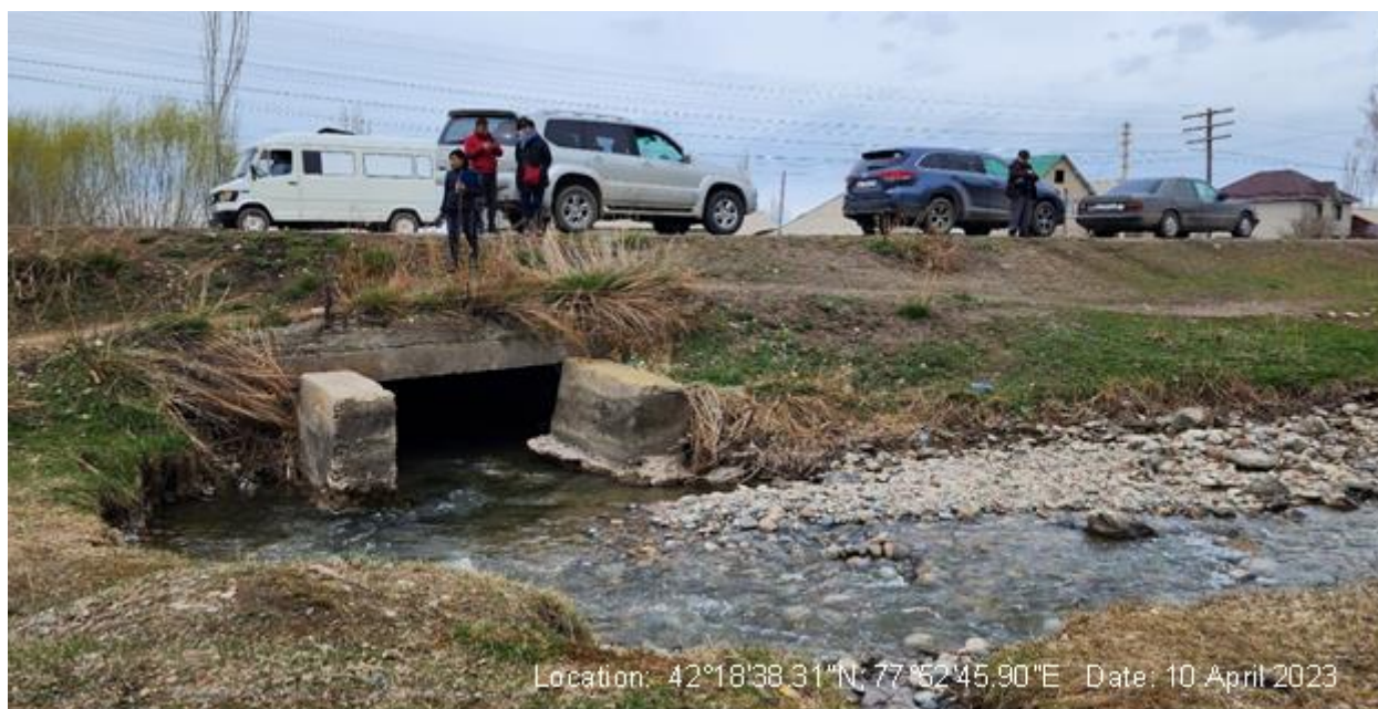
Рис. 17: Существующая водопропускная труба в селе Дархан (КМ 170+160).
