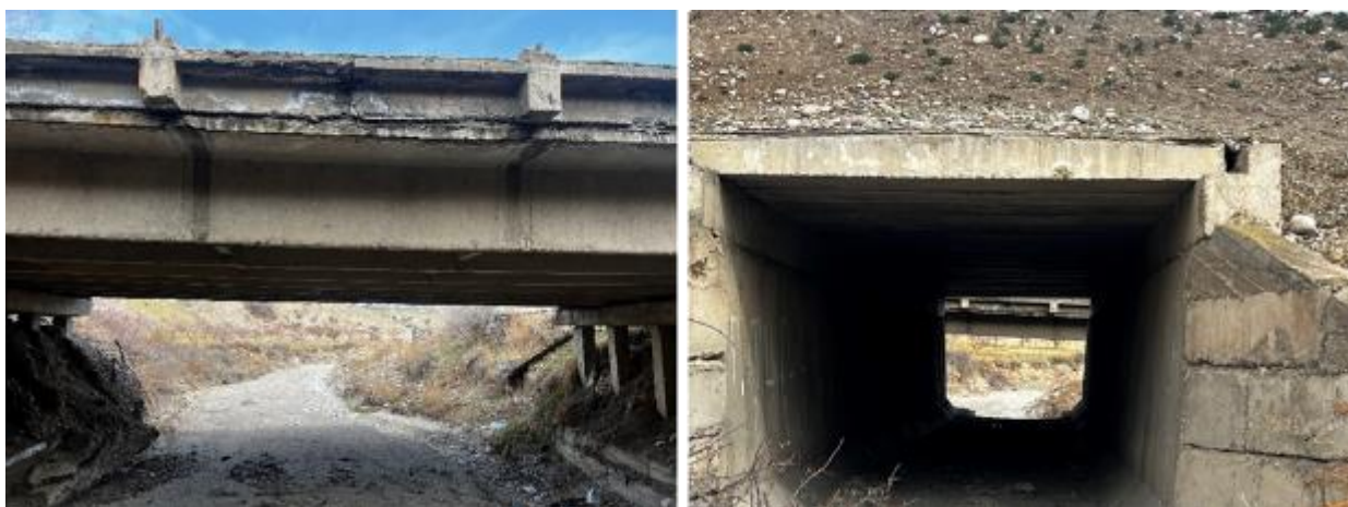
Рис. 67: Старый мост и канал аварийного сброса (водопропускная труба).
